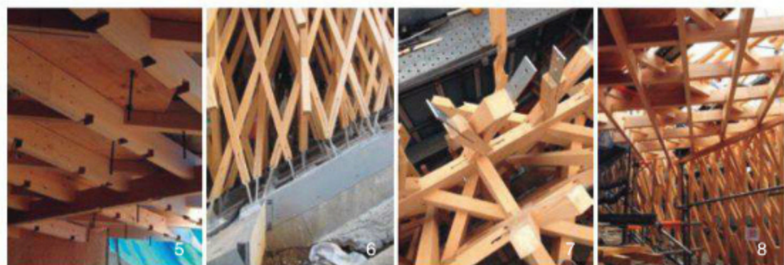
5.6.7.8. 微熱山丘東京南青山店施工過程與結構細節。
